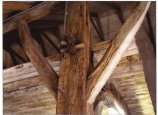
Detailfoto van de ankerbalkconstructie. Op de gebintstijl en op de twee schoren (of korbelen) zijn telmerken zichtbaar. Gebinten werden eerst op maat gemaakt en vervolgens, op de plek van bestemming, in elkaar gezet.
