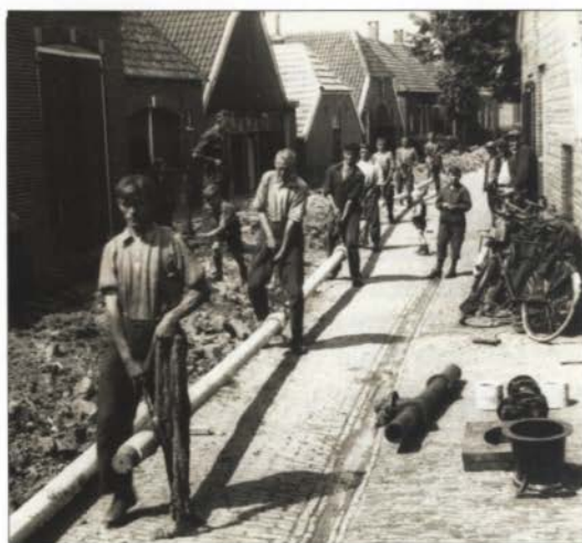
Aanleg van waterleiding aan de Huttenwal in Rijssen, 1936. De buis wordt in de geul getild. Bron: Archief gemeente Rijssen-Holten.
