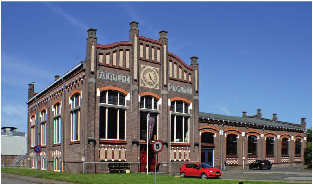
Het ketelhuis van de Koninklijke Stoomweverij
