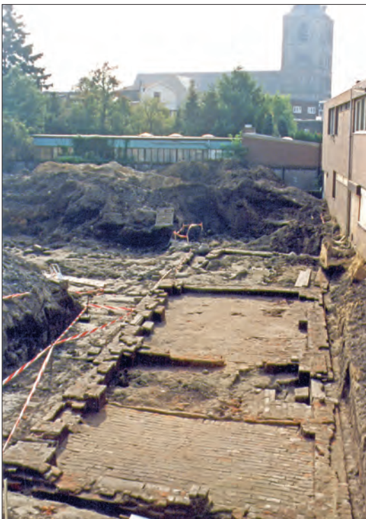
De fundering van een groot stenen gebouw, afmeting 16 x 6 meter. Foto Jos Oude Essink Nijhuis
