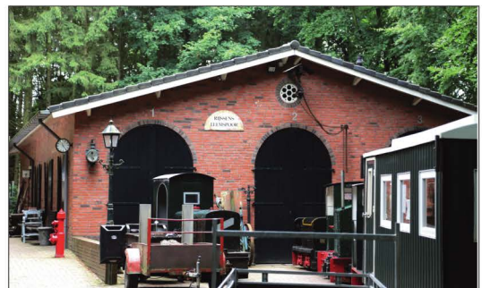
Remise van de Leemlijn in Rijssen.
