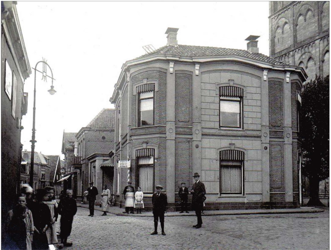
Dit is het pand na de verbouwing door architect Van der Goot.
