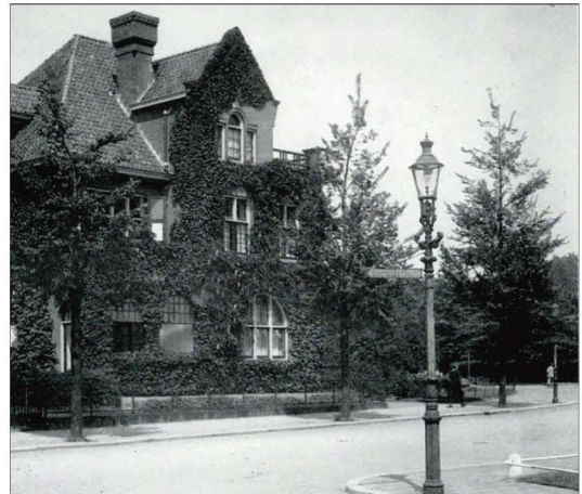
Gaslantaarn omgebouwd voor elektrische gloeilamp.
