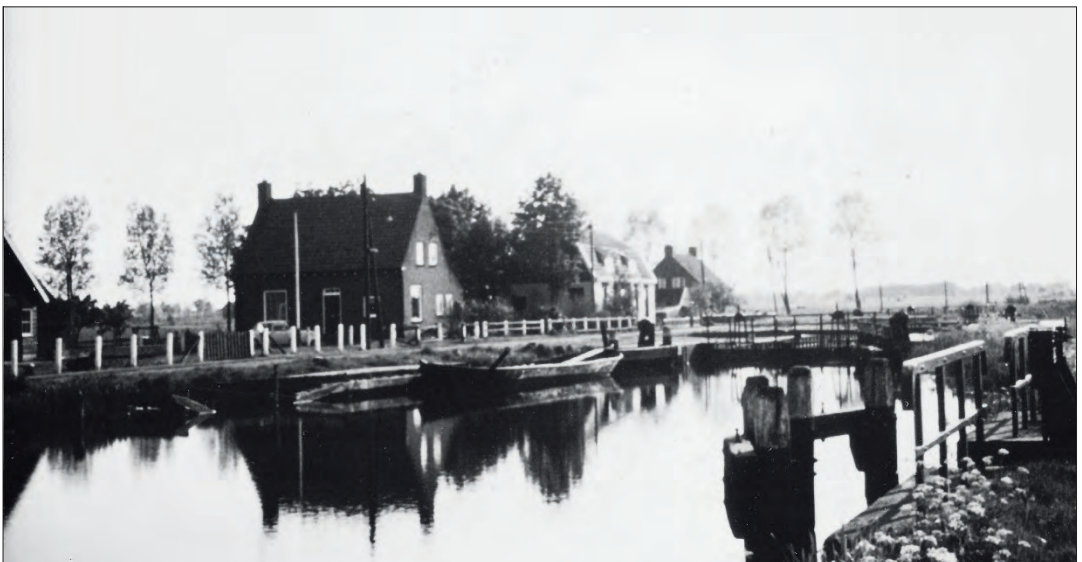
Sluis V wordt als de plek bij uitstek beschouwd waar Vroomshoop zijn oorsprong vond.
