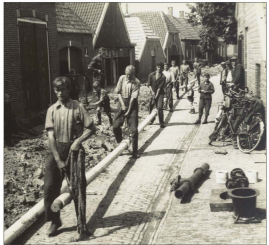
Aanleg van waterleiding aan de Huttenwal in Rijssen, 1936. De buis wordt in de geul getild. Bron: Archief gemeente Rijssen-Holten.
